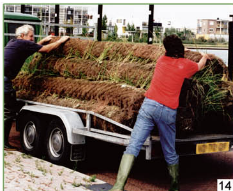
8. Déchargement de géonattes. - 9. Stockage de géonattes végétalisées. - 10. Battage des pieux avec cloche installée sur BRH. - 11. Manutention de fascines d'hélophytes. - 12. Installation de géonattes. - 13. Aqua-pépinières, bassins de production. - 14. Déchargement de fascines d'hélophytes. 15. Livraison par voie fluviale.
