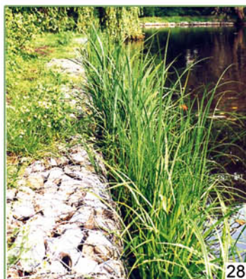
24. Chariot avec 1000 Phragmites en godets de 6x12 cm. - 25. Ces godets sont plus faciles à planter et ancrés plus profondément. - 26. Après installation des géonattes, rajouts de Typhas. - 27. Fascines d'hélrophytes posées dans les enrochements. - 28. Fascines d'hélrophytes fixées aux gabions. - 29. Végétation un an après la pose. - 30. Suède : Géonattes en pied de berge et géofilet coco au dessus.
