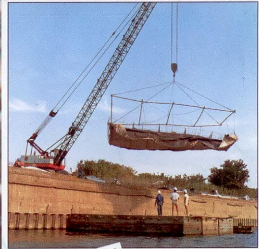
Chargement de l'enveloppe sur le ponton de transport
